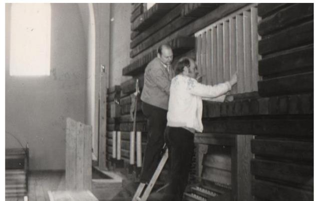
Das Schwellwerk der Orgel wird durch Monteure der Firma Jehmlich geschlossen – 17. Mai 1978
